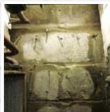
2. Поверхность ФБС-блоков, подготовленная для инъектирования
