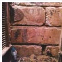
1. Поверхность ФБС-блоков, подготовленная к «запечатыванию» ремонтными составами
